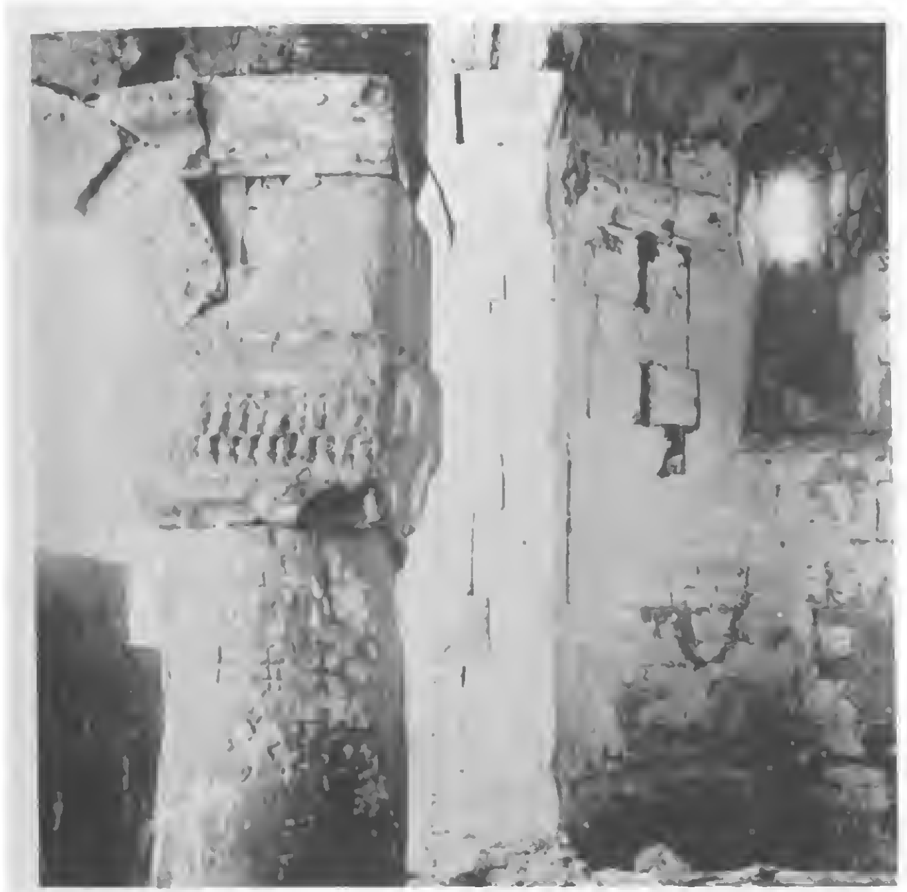
FIG. 14. — Adilcevaz (Altziké) : colonne et chapiteau de la croisée du transept.
